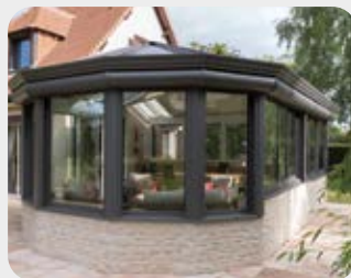
Muret maçonné en pierres
