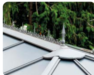
Pointe et crête de toiture
