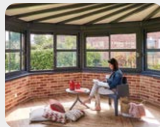
Muret maçonné en briquettes
