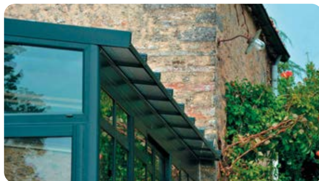
Sans corniche et dotée de traverses, une véranda se fait ici verrière.
